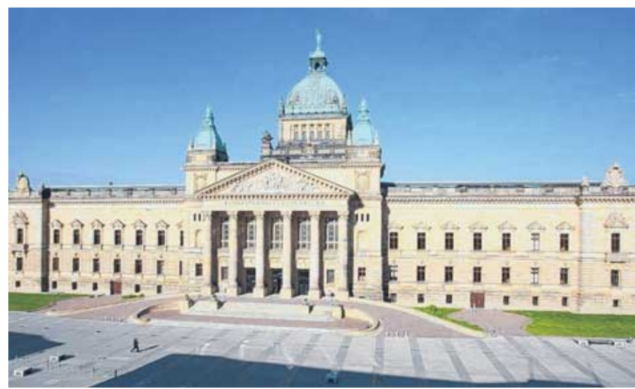
Das Reichsgerichtsgebäude ist seit zehn Jahren Sitz der obersten Verwaltungsinstanz – das wird mit einem Tag der offenen Tür im August gefeiert. Foto: André Kempner
